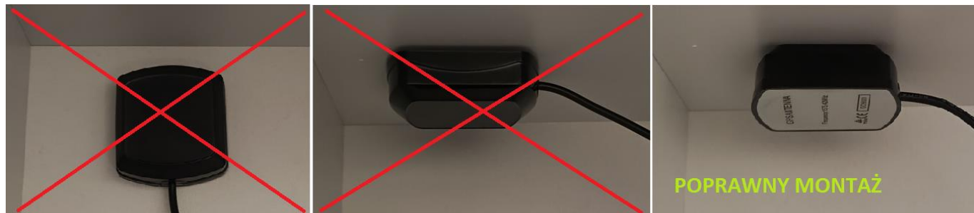
Rysunek 8. Sposób montażu anteny GPS w szafce instalacyjnej
